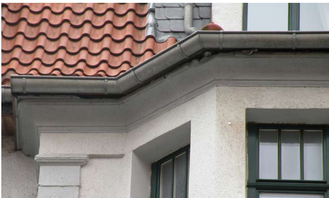
Erhalt von Einflugmöglichkeiten an der Altbaufassade
