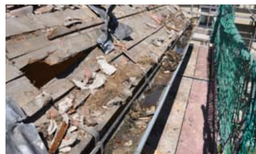
Abgedecktes Dach mit Nistmaterial
