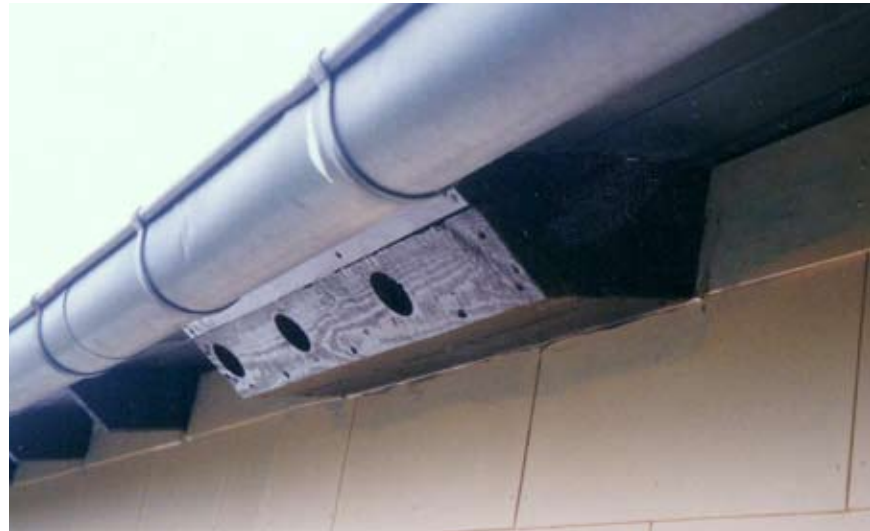
Passgenauer Holzkasten zwischen Balkenköpfen
