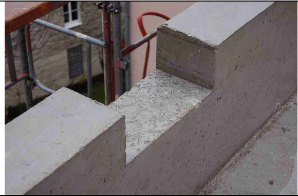
2 Aussparungen für Nistkästen im Rohbau
