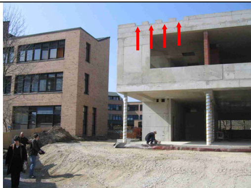
5 Aussparungen im Rohbau zur Aufnahme der Nistkästen
