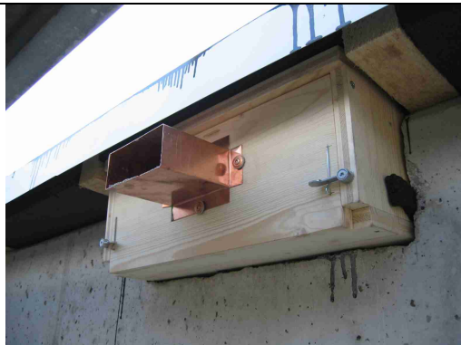
3 Eingesetzter Nistkasten mit Kriechtunnel durch die Wärmedämmung
