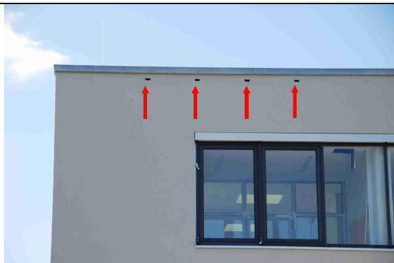
7 Vier Mauersegler-Brutnischen am Dachrand
